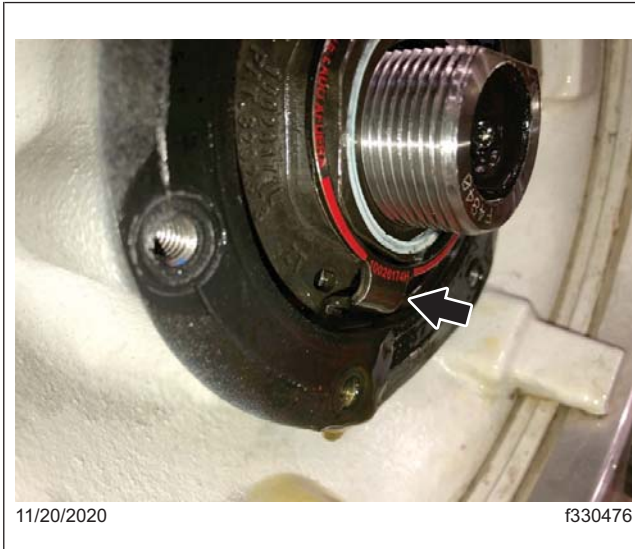
Fig. 4, La lengüeta inferior del anillo de resorte no está completamente instalada en el orificio de bloqueo de la tuerca de husillo
