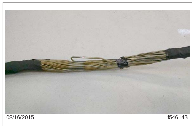
Fig. 7, Superposición agregada al área dañada del arnés
