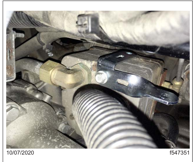
Fig. 17, Soporte separador nuevo
