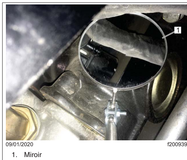
Fig. 3, Inspection avec un miroir
