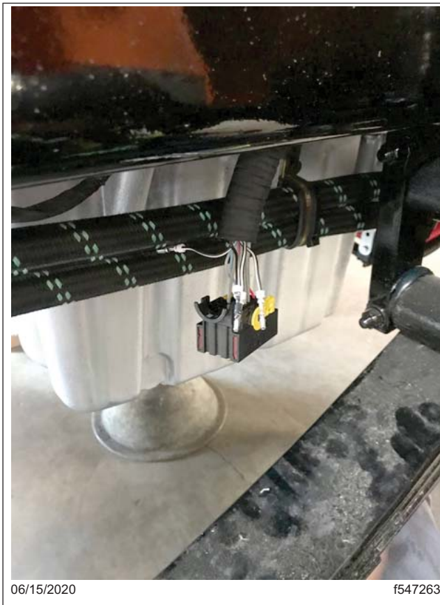
Fig. 14, Extracción de cables GNDE
