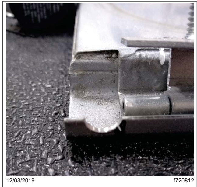
Fig. 2, Trimmed Baggage Door Flange
