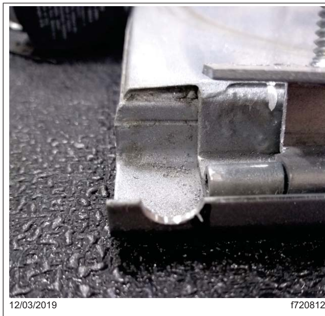
Fig. 2, Trimmed Baggage Door Flange
